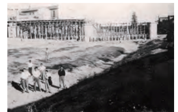
Construcció del pont vell, Paiporta 1926. Foto cedida per Josefina Torregrosa. Arxiu Museu de la Rajoleria.
