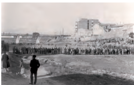
Vista del camp de futbol en el barranc, Paiporta 1960. Foto cedida per Diego Roldán. Arxiu Museu de la Rajoleria.
